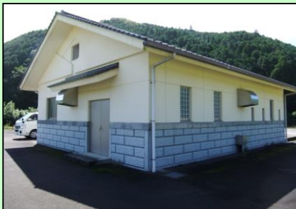
奈路地区農業集落排水処理施設の建屋
