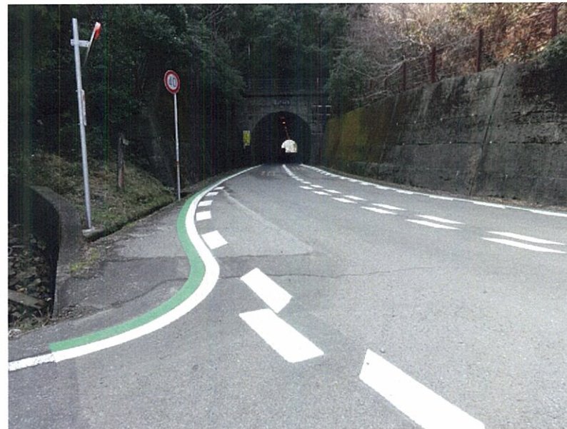
No.2 鎌田トンネル グリーンベルトの設置 白線の塗り直し 減速マークの設置等
