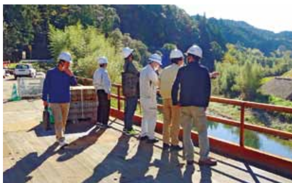
④大野見地区の県道改良事業を調査する産業建設民生常任委員⑤仮称2号橋の橋げたの設置作業（久万秋工区）
