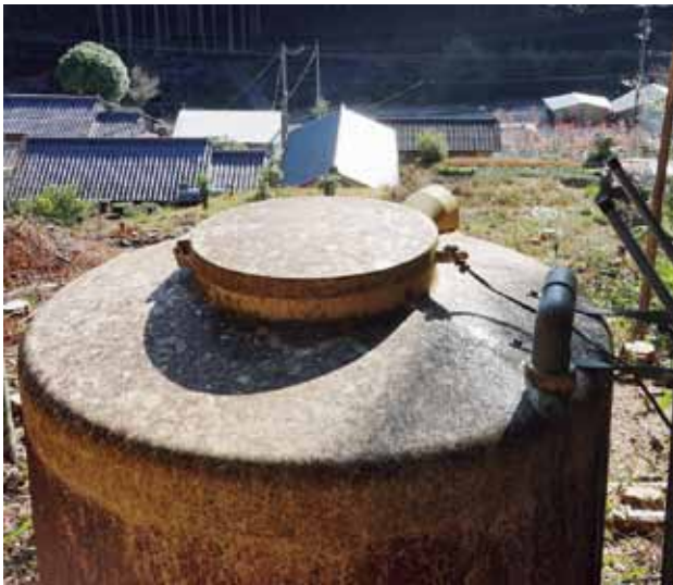
地区の高台にある給水タンク。2*ほど離れた取水口からパイプで水を引き、一度タンクに蓄えて各家庭に送る (大野見地区)
