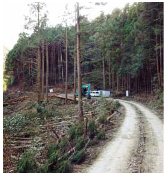
木材搬出のための林道整備 (久礼・大坂地区)
