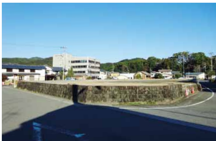
建物解体後の旧役場庁舎跡地
