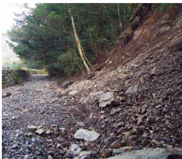
山が崩壊して大量の土砂が堆積した笹場川
