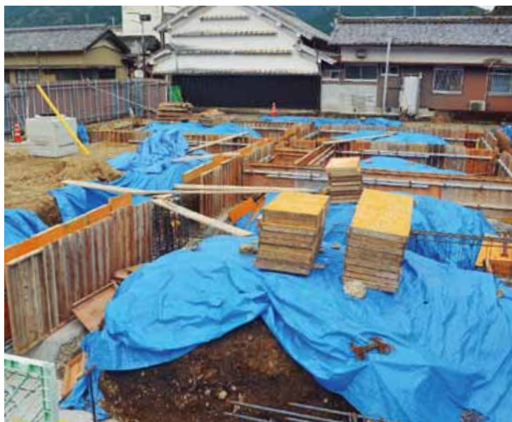
完成後の機能充実の声がある新上ノ加江公民館の基礎工事
