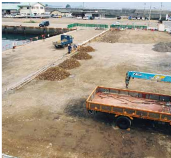
久礼新港の耐震バース化の工事
