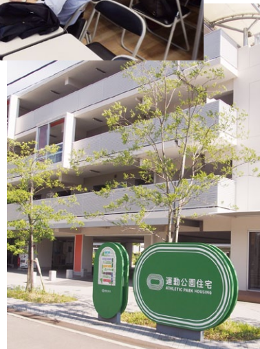
総合運動公園につくられた災害住宅
