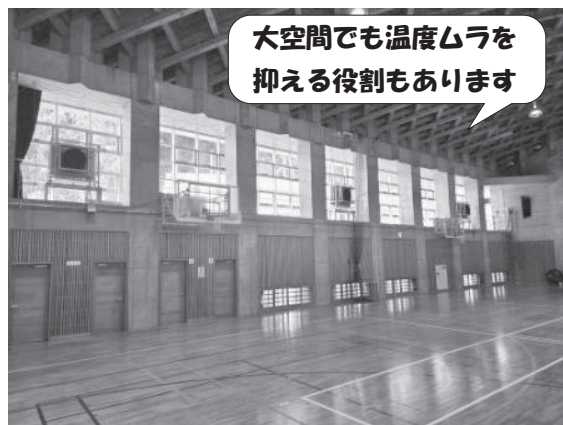
空調機全7台設置
