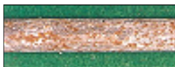
（腐食グレード：Ⅲ）
