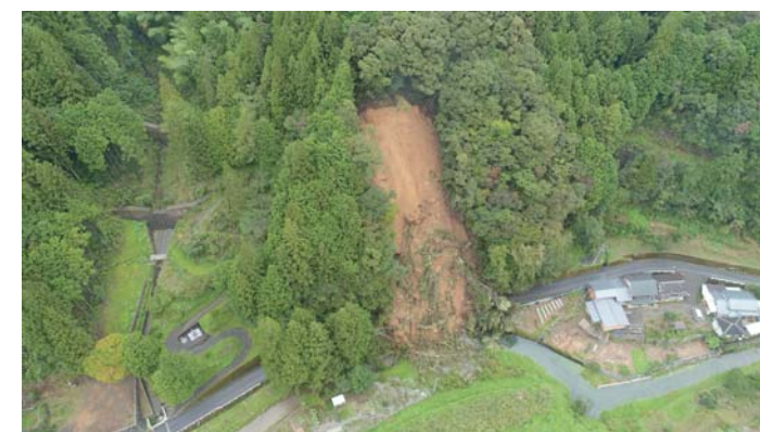
台風11号(平成26年8月)の影響による大規模な法面崩壊
