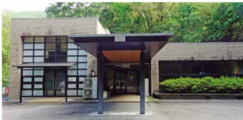
築40年が経過し、運用が懸念される中土佐町斎場
