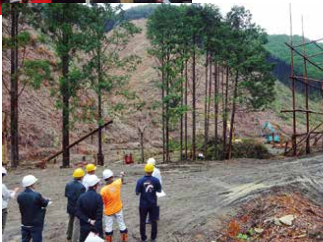
久礼指川での現場調査の様子（4月20日）
