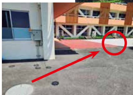
ポンプ槽を別へ新設
