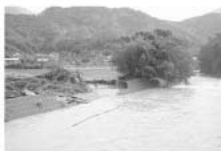
久礼川橋下流決壊現場
