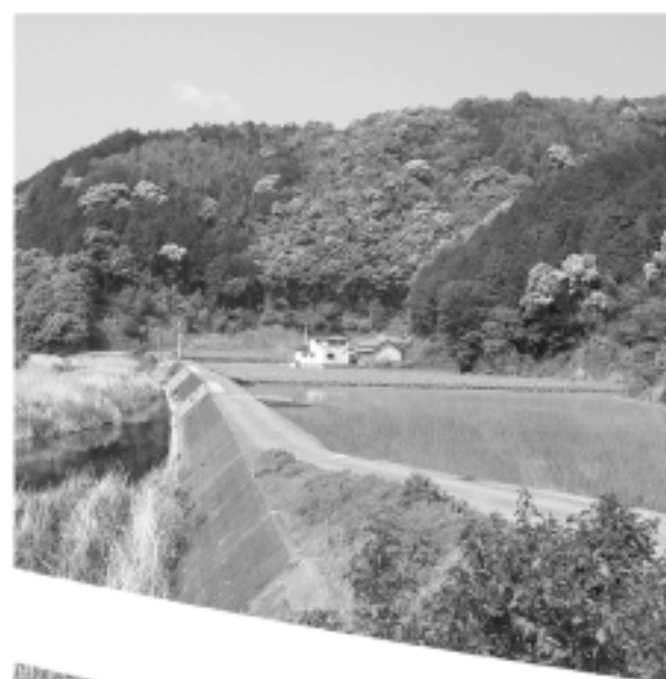
危険な町道本越線
