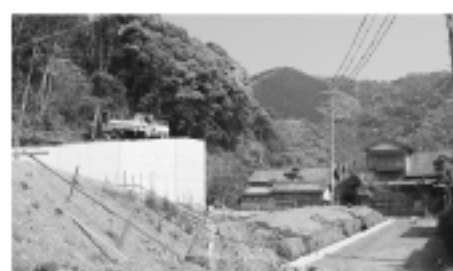
上ノ加江避難路、排水対策工事現場
