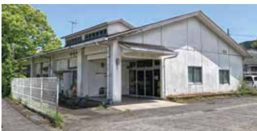
キッズパークへ改修予定の旧福祉施設のじぎく荘
