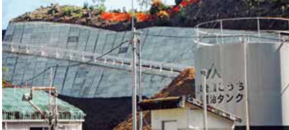
早期完成が待たれる笹場地区配水池
