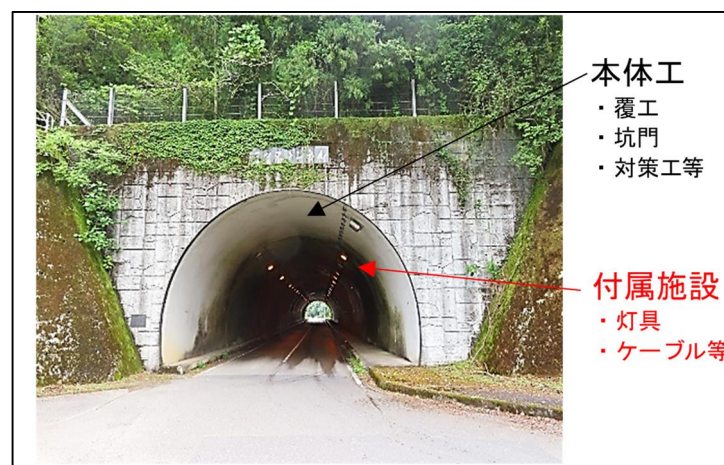
図 2-1 トンネル構造
