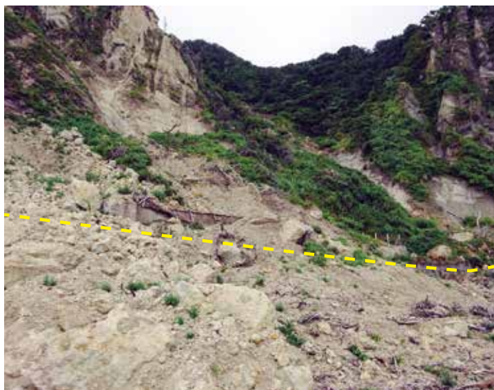
山の崩落による大量の土砂が道路をふさいでいた。山留などの構造物が見えるので点線の辺りが道路と思われる（珠州市大谷地区）
