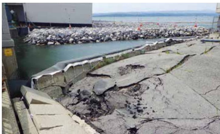
▲湾に面して建っているホテルの基礎部分には浸食による倒壊を防ぐため割石が敷き詰められていた。(和倉温泉)
