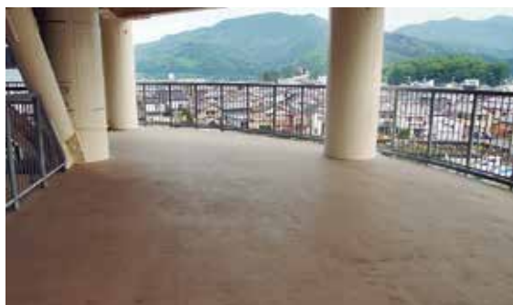
雨、風、寒さに避難者は耐えられるか (久礼地区の避難タワー)
