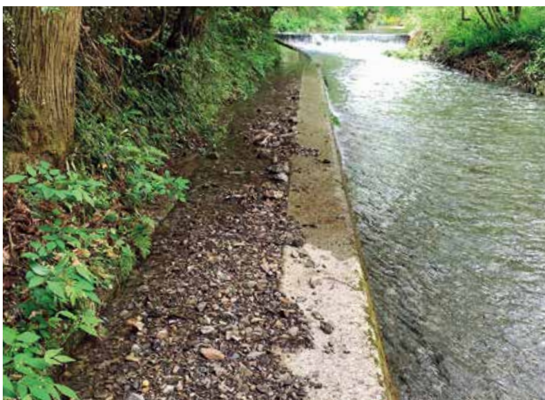
大雨や台風などで川が増水するたびに水路が土砂でふさがる用水路（久礼中大坂）
