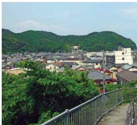
津波による浸水が想定される地域（久礼）
