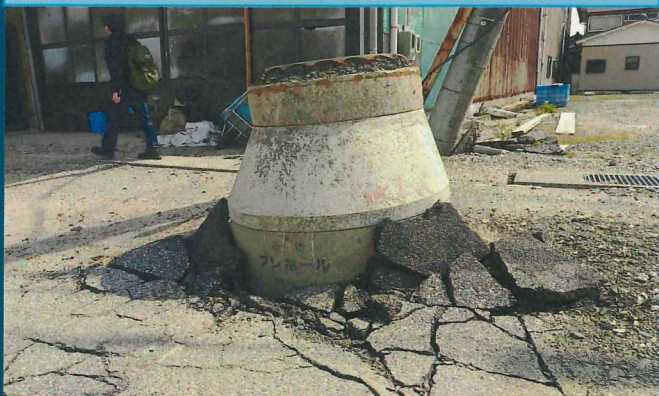
マンホールが浮き上がっています
