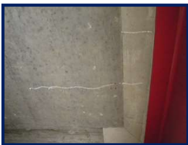
床板のひび割れ
