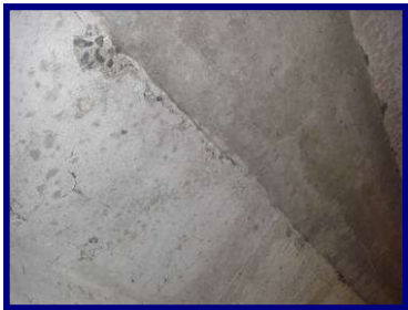
床板のひび割れ
