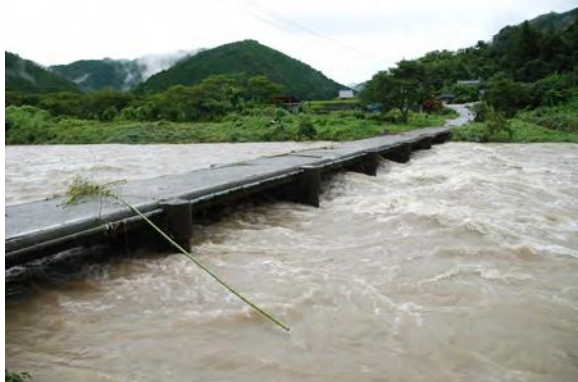
集落間を結ぶ沈下橋は、集落の人々の生活道として利用される増水時には沈むことを前提とした川とともに生きる文化を伝える象徴的な要素である
