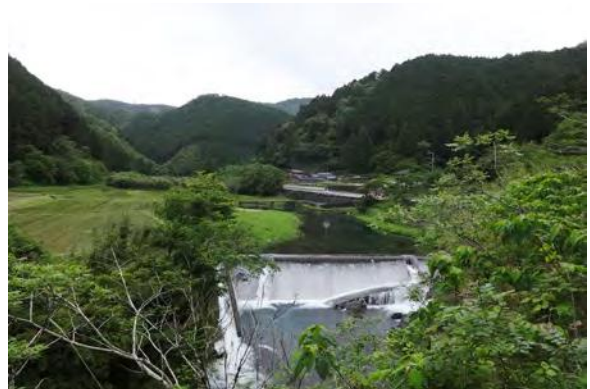
川沿いの狭小な平地は農地に、対岸の山裾に家屋を配することで集落としての営みが維持されている 川には下流の集落を潤す取水堰や渡河のための沈下橋がある（高樋）
