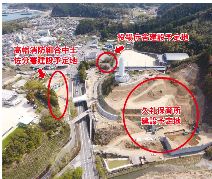
平成32年度末の完成を目指し工事が進む公共施設移転等事業
