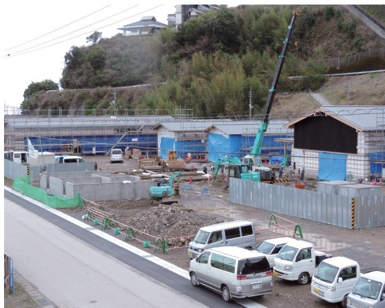
建設が進む「みなとオアシス」としても登録される「道の駅なかとさ」
