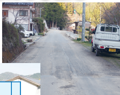
舗装工事が行われる町道押谷線（大野見萩中）
