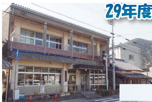
建て替えのための設計委託料が計上された上ノ加江公民館
