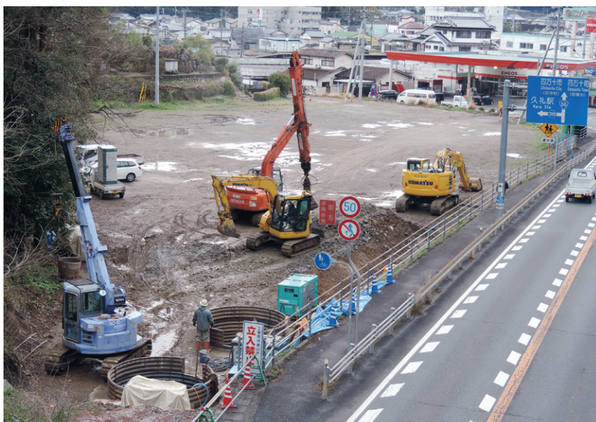
用地造成工事の残土の運搬にも利用される国道をまたぐ橋梁の下部工事
